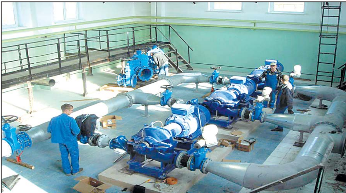
Монтаж насосной станции в Нефтегорске специалисты компании «Самэнви́ро» произвели в кратчайшие сроки.
