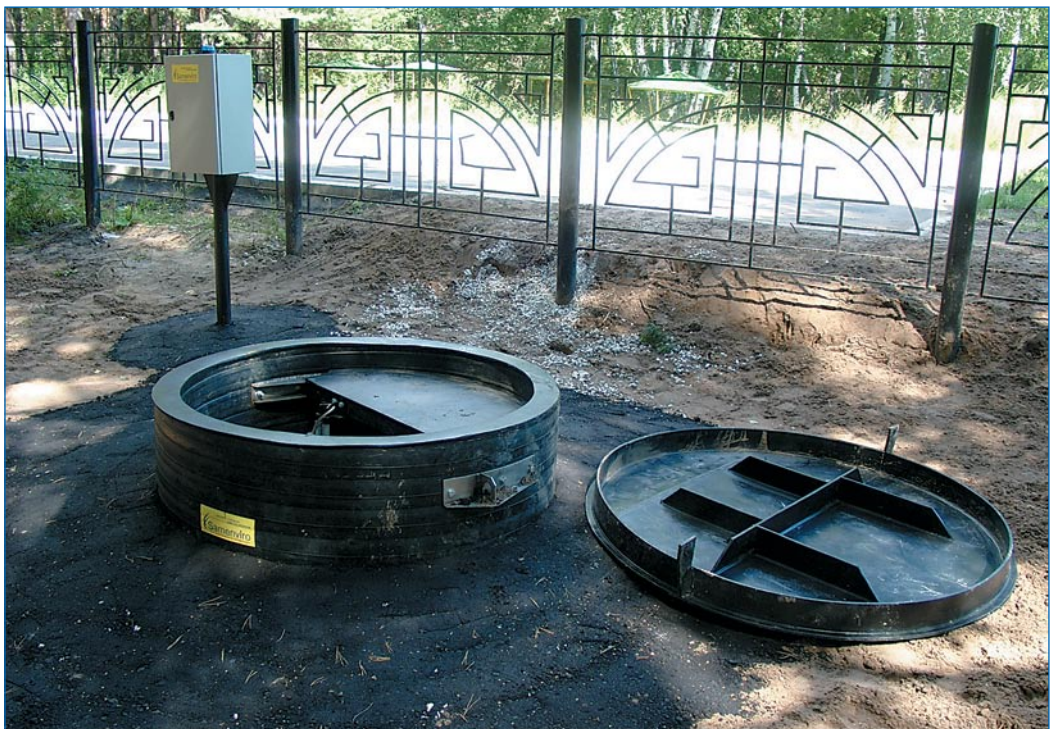
Смонтированная модульная насосная станция (Самарская обл.)
