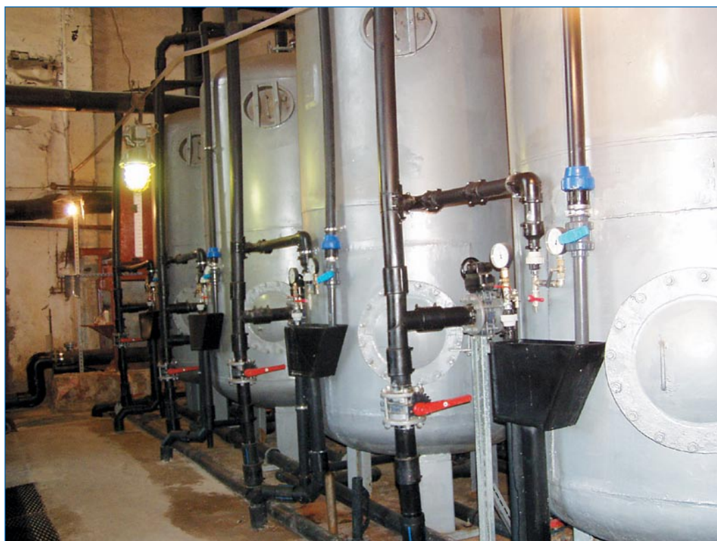
Реконструкция станции водоподготовки центральной котельной (фрагмент) г. Нефтегорска (Самарская обл.)
