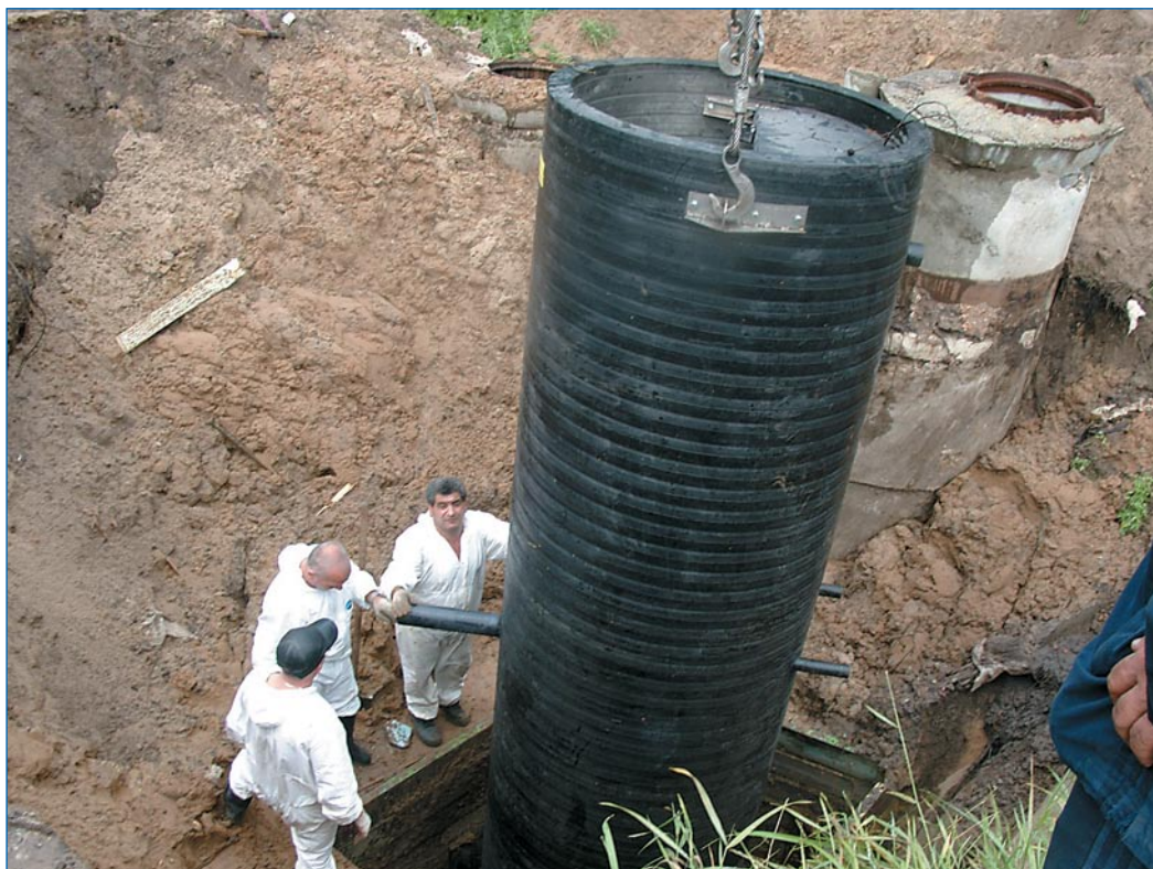
Монтаж модульной насосной станции
