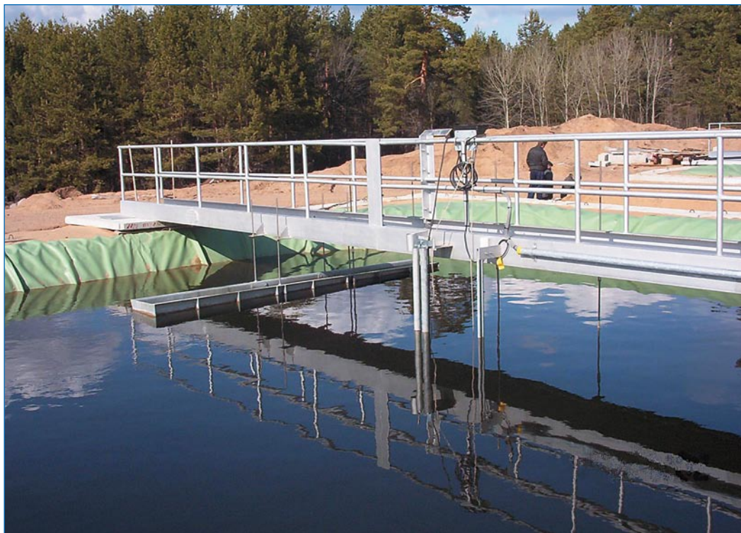
Очистные сооружения УР65/10 в пос. Волжский (Самарская обл.)
